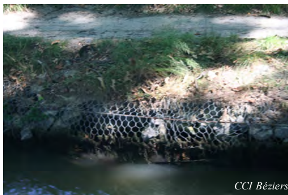
Le palplanche (à gauche) et le gabion (à droite), deux solutions pour maintenir les berges
