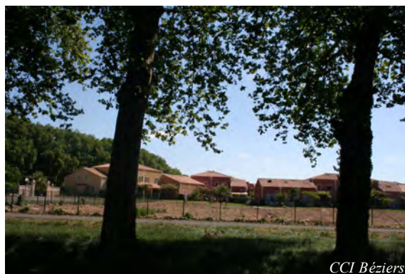
La Résidence Odalys «Les Berges du Canal » à Béziers
